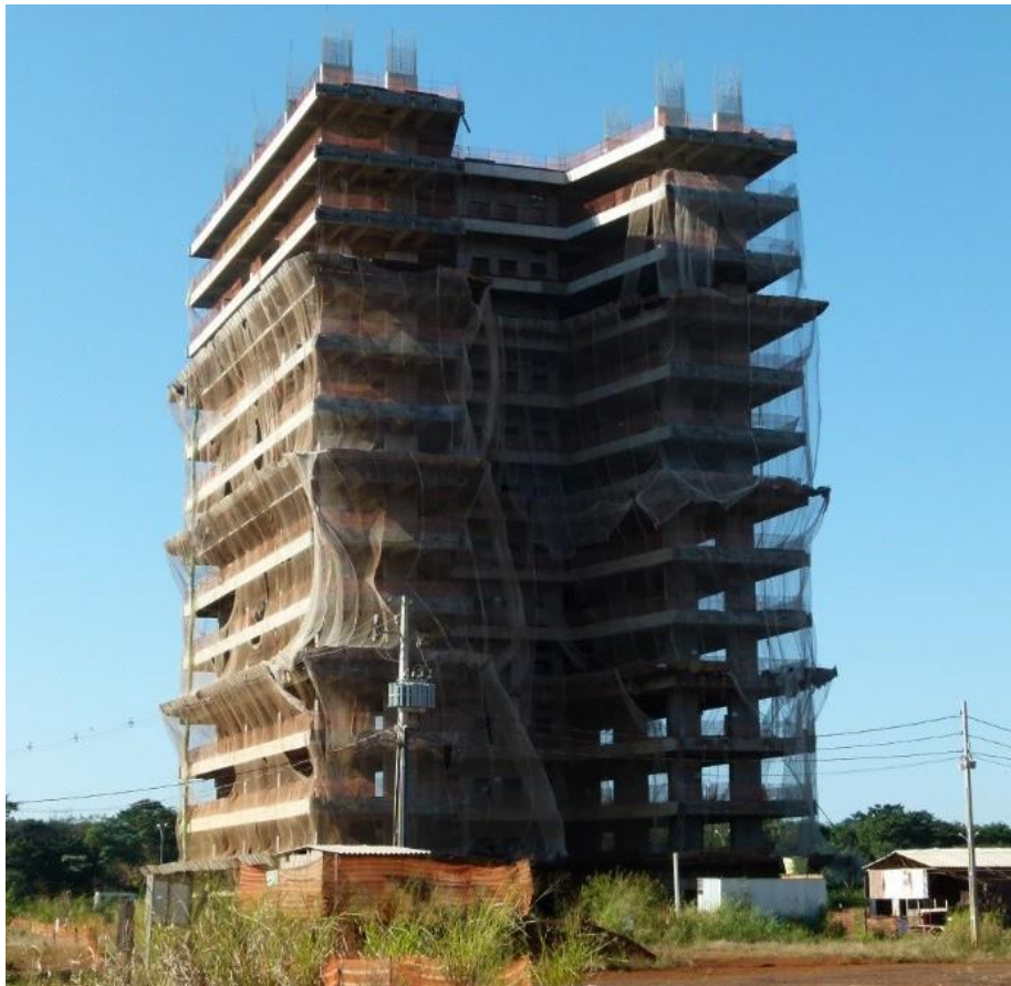
Edifício central com estrutura parcialmente construída até o 13º pavimento
