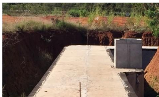
Figura 12 – Proteção mecânica da galeria técnica não coberta com aterro
