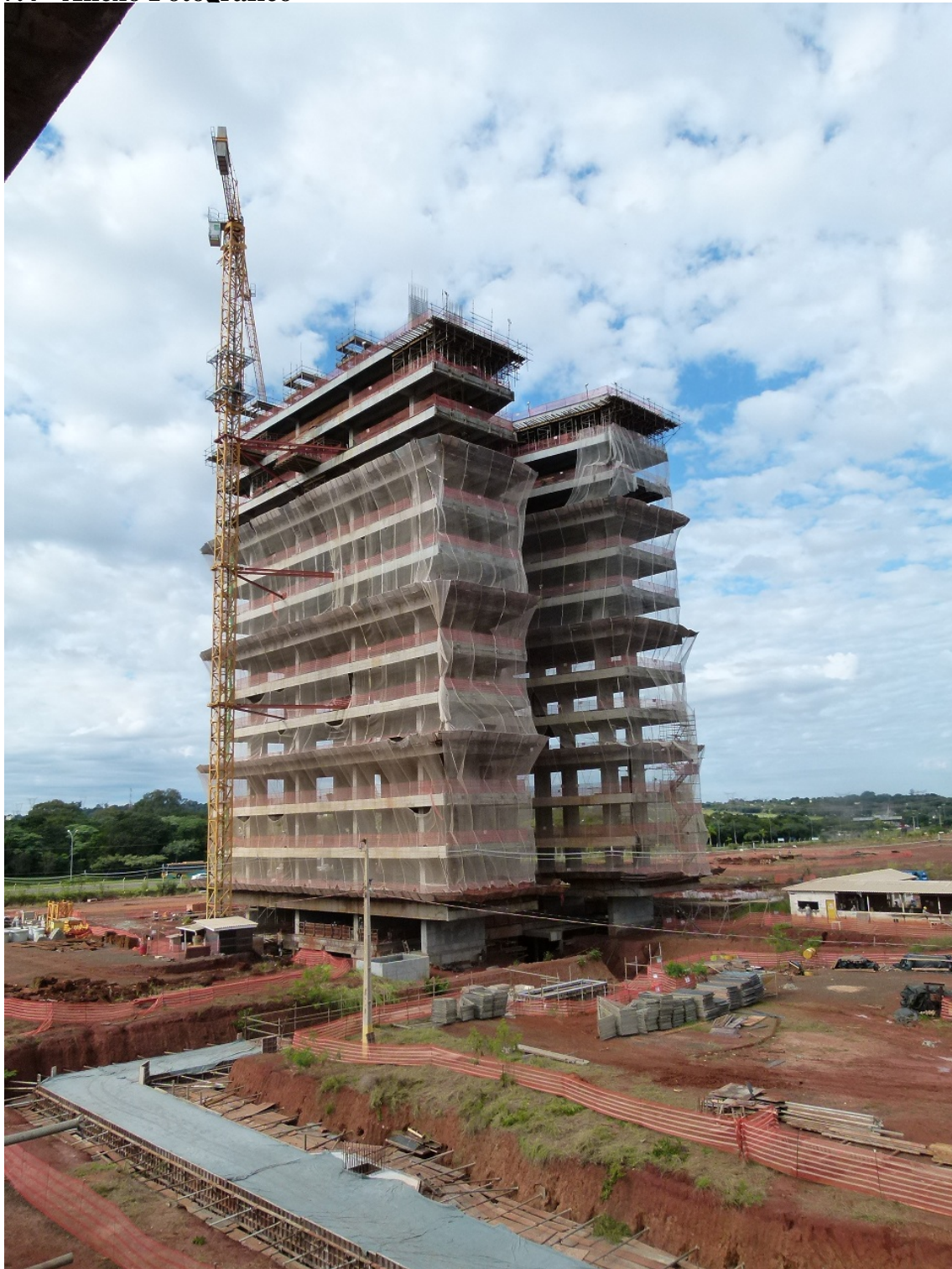
Estrutura do Edifício Central, executada até o 13º pavimento
