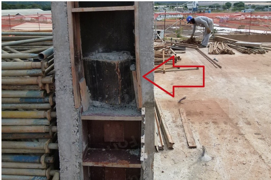
Foto 7 - Forma arrebitada durante a execução da estrutura do 3º pavimento do Prédio de Aulas
