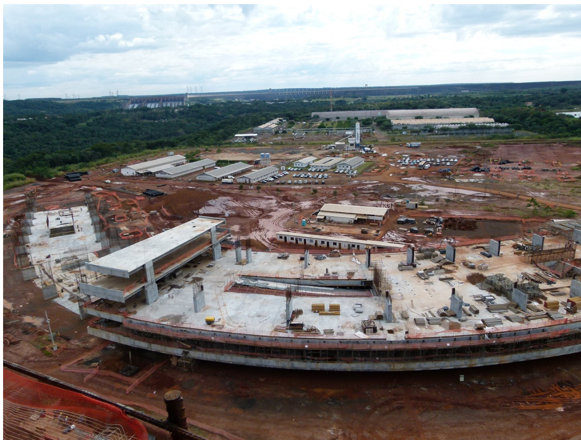
Estrutura do Prédio de Aulas, executada parcialmente até o 2º pavimento
