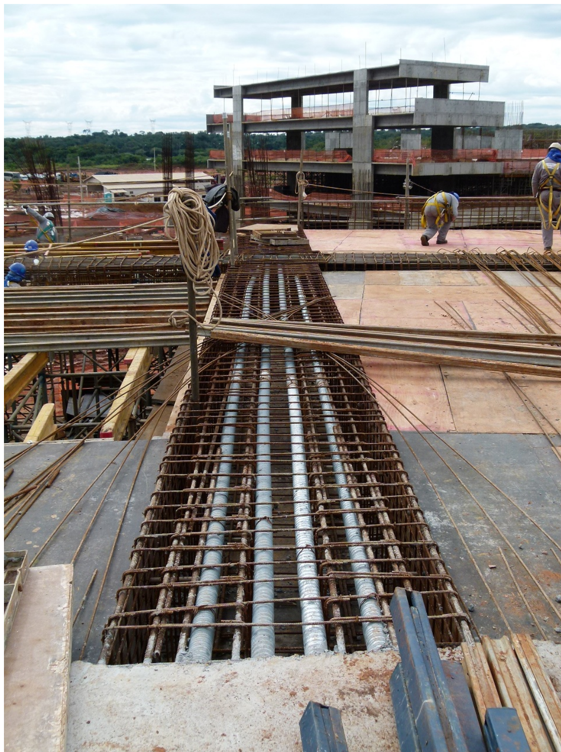
Execução de serviços de montagem de armadura em viga protendida - Restaurante
