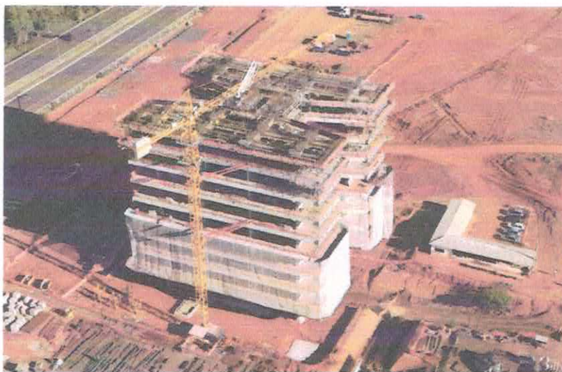
Foto aérea da obra tirada em 17/08/2013
