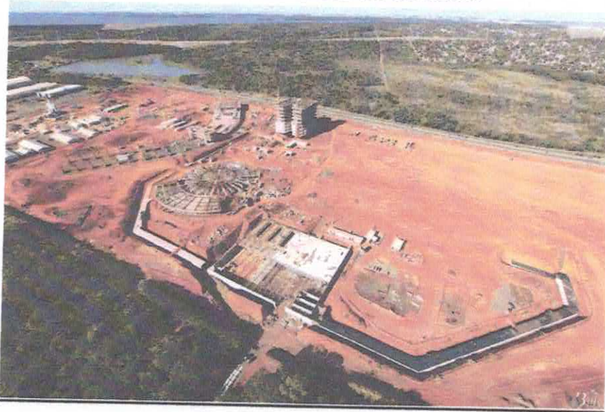
Foto aérea da obra tirada em 17/08/2013
